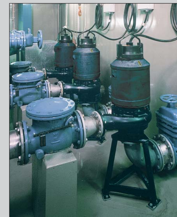
Насосы Grundfos SEN из нержавеющей стали с охлаждающим кожухом
